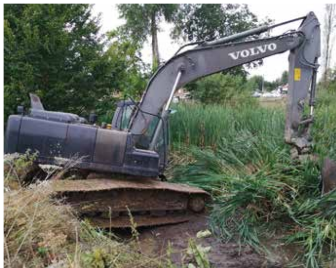
En cours de réalisation
