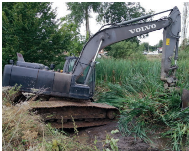
En cours de réalisation
