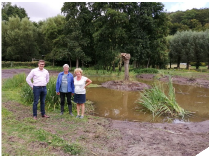
Photo prise à la fin des travaux.
